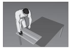
Укоротите нижний сегмент калитки по высоте снизу на 50 мм.
