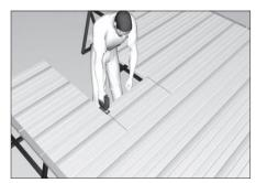
Поочередно в каждой панеле вырежьте внешний контур калитки с помощью электролобзика.
