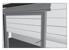
Установите на верхний сегмент калитки верхний горизонтальный Ц-профиль и боковые Ц- и П-профили. По месту отмерьте их длину, ориентируясь по середине стыков панелей, и отрежьте с помощью ножовки по металлу.
